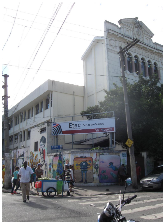
Figura 3 - Edifícios da Etec Carlos de Campos, da década de 1930, com o novo prédio de 1976. Foto: Maria Lucia M de Carvalho, 2016.
