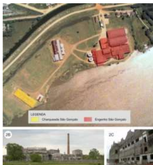
Figura 2 – Charqueada e Frigoríficos. (2A) Charqueada São Gonçalo e Engenho São Gonçalo. Fonte: GOOGLE EARTH, 2012. (2B) Frigorífico Casarin, vista do Canal São Gonçalo (2C) Frigorífico Anglo, grandes alterações na estrutura do edifício. Pelotas. RS. Fonte: Foto do autor, 2012.
