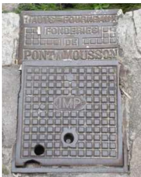
FIGURA 12 – Inscrição em tampa de esgoto. Fonte: Acervo da pesquisa
