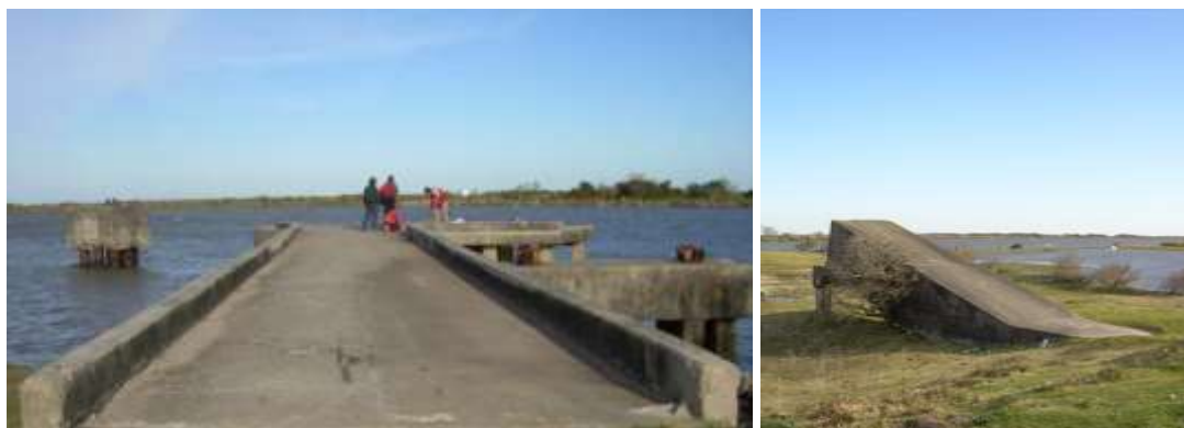
Figura 6 - Instalações Portuárias da CIMENSUL (Matarazzo). Fonte: SALABERRY; MENDONÇA; LÚCIO, 2012.
