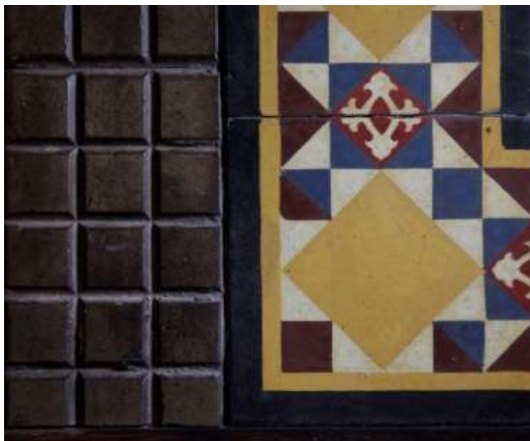
Figura 2: Exemplo de ladrilho texturado, em uma cor; e liso, em várias cores, com padrão de desenho complexo.
