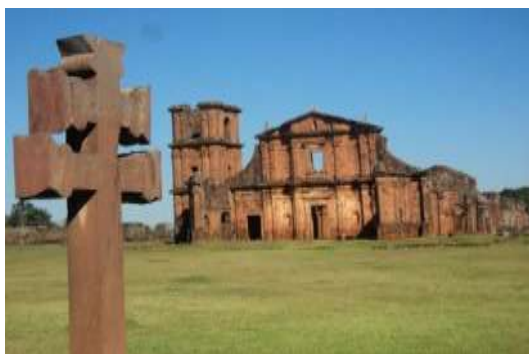
Figura 2 Fachada das Ruínas de São Miguel das Missões e a Cruz Missioneira.
