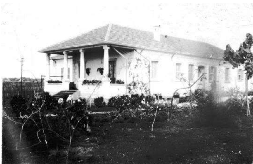
FIGURA 5 – Imagem da “Casa do Superintendente”, uma das seis casas do complexo construído pela Companhia Estrada de Ferro São Paulo-Paraná, para hospedar engenheiros e funcionários de alta patente da ferrovia. Foto de 1937.
