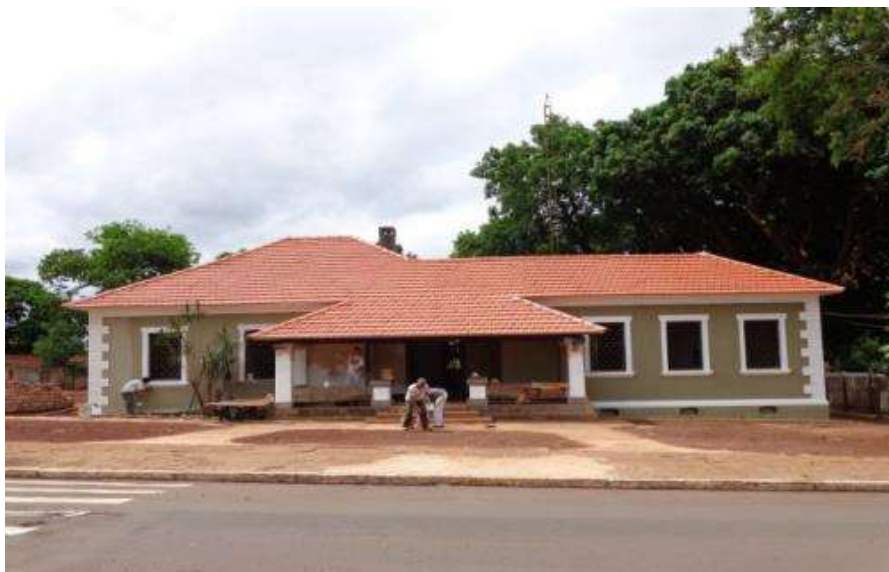
FIGURA 6 – Imagem da “Casa dos Ingleses” durante a fase de restauração. A intenção da PMO foi a de manter fidelidade aos traços arquitetônicos da época. O imóvel é um dos dois que foram incluídos no processo de tombamento pela CMPPH. Os únicos que não sofreram alterações na estética no decorrer da urbanização de Ourinhos, iniciada a partir de 1950. Foto de 2013.
