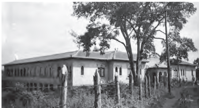
Figura 4 – Educandário Pestalozzi em construção, em 1951.
