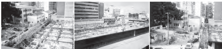
Figuras 12, 13 e 14 – Área correspondente à Demolição da Cantina, infraestrutura dos Blocos B e C. Fotografias: Elisa A. N. Takahashi, de 1992. (TAKAHASHI, 2019)
