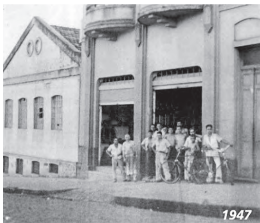
Figura 6 – Instalações da Cerâmica Stéfani, em 1947.
