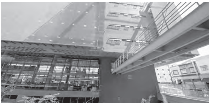
Figura 30 – Edifício da Administração Central do Centro Paula Souza.
