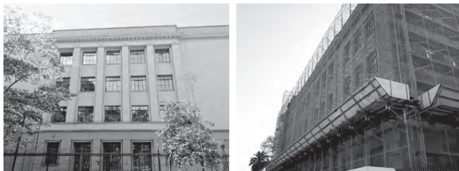
Figuras 21 e 22 – Edifício Santiago, em 2019, e seu restauro na década 2010.
