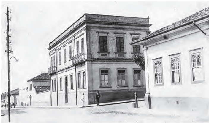
Figura 3 – Sede da Câmara Municipal de Limeira, na década de 1920.
