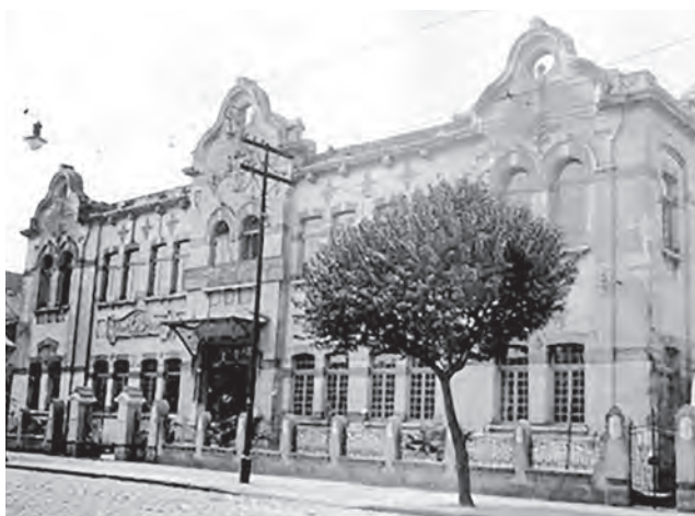
Figura 4 – Fachada do edifício escolar na Rua Piratininga.
