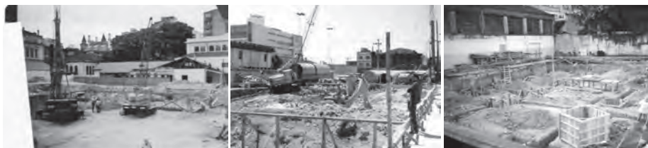
Figuras 6, 7 e 8 – Área correspondente a Demolição das Alas, e início da construção do Bloco A. Fotografias: Elisa A. N. Takahashi, em 1989. (TAKAHASHI, 2019)
