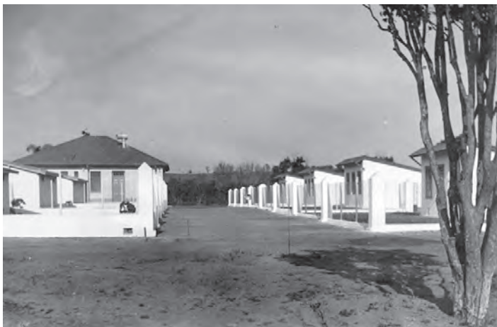
Figura 4 – Vista parcial do Aviário.
