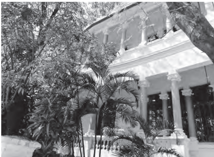
Figura 2 – Edificação da Etec Carlos de Campos, em 2019.
